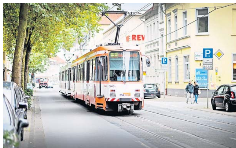
Da, wo die Stadtbahn der Linie 3 auf diesem Foto fährt, soll der Hochbahnsteig der Haltestelle Marktstraße gebaut werden. Foto: Starke
