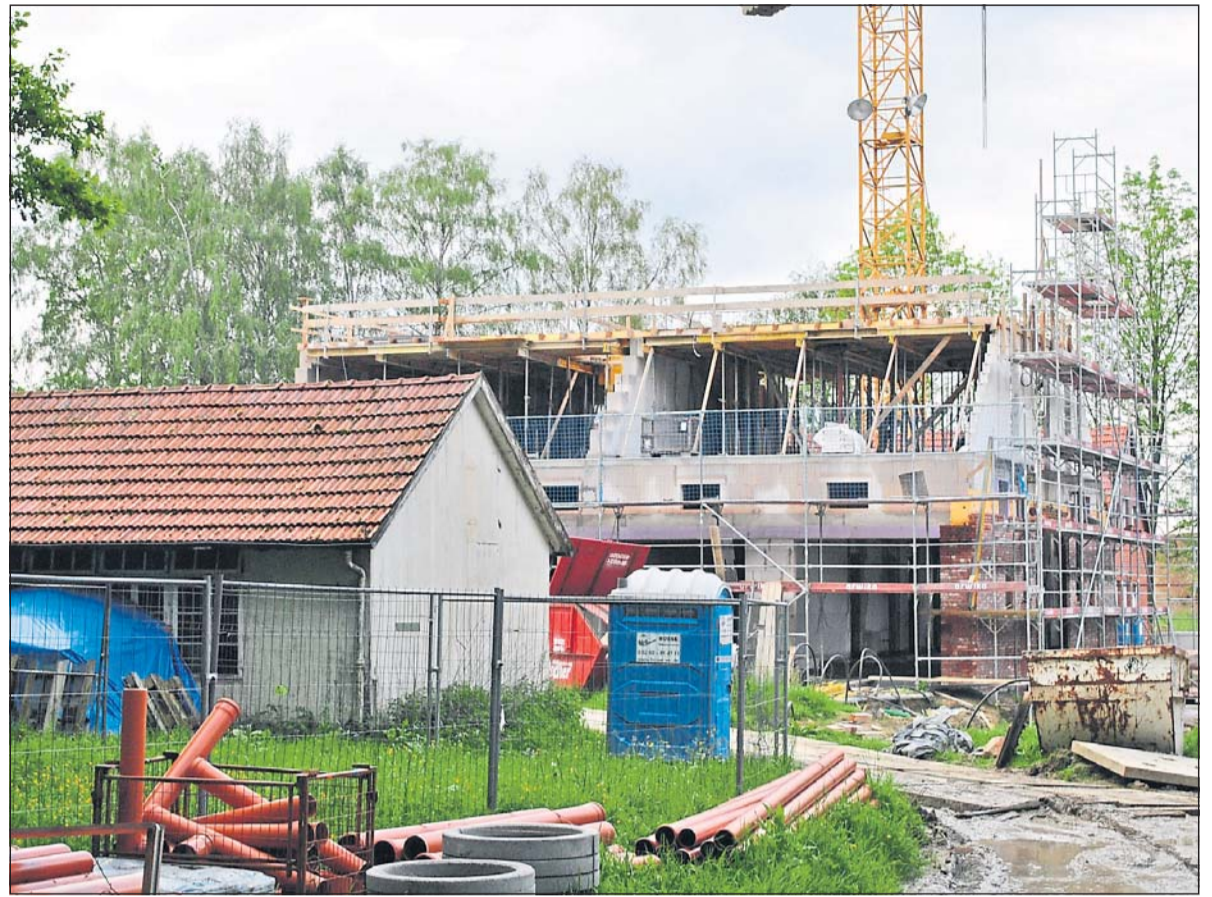
Noch Baustelle: die Wohnanlage »Gut Wittenbach«. aus dem 16. Jahrhundert stammende Ensemble nun Nach Baustopp und Ärger mit Behörden wird das zügig weiter umgebaut. Foto: Volker Zeiger
