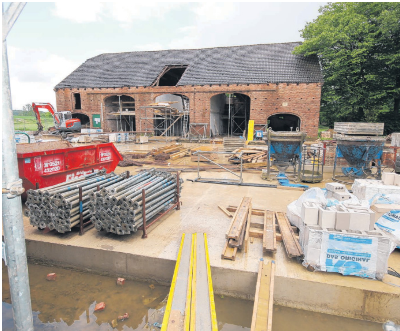
1923 errichtet: Zurzeit sind die Mitarbeiter der Firma Langenscheidt damit beschäftigt, die alten Wände im Inneren des Gebäudes durch neue zu ersetzen. Voraussichtlich bis zum August dauern hier die Arbeiten. FOTO: SYLVIA TETMEYER
